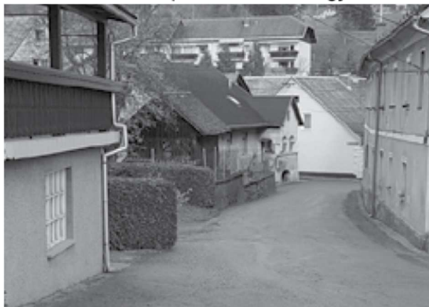
Slika 23: Sanacija ozkih grl med Zgornjo in Spodnjo Muto – spodnji predel klanca
